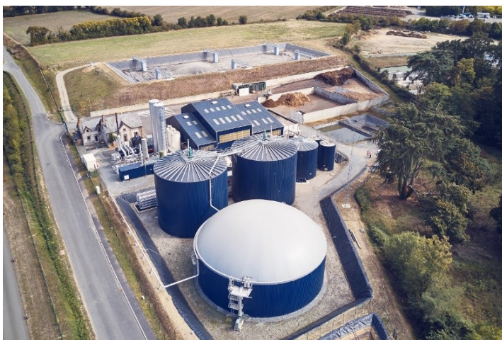
Vue aérienne du site de méthanisation Biogaz du Pays de Château-Gontier
